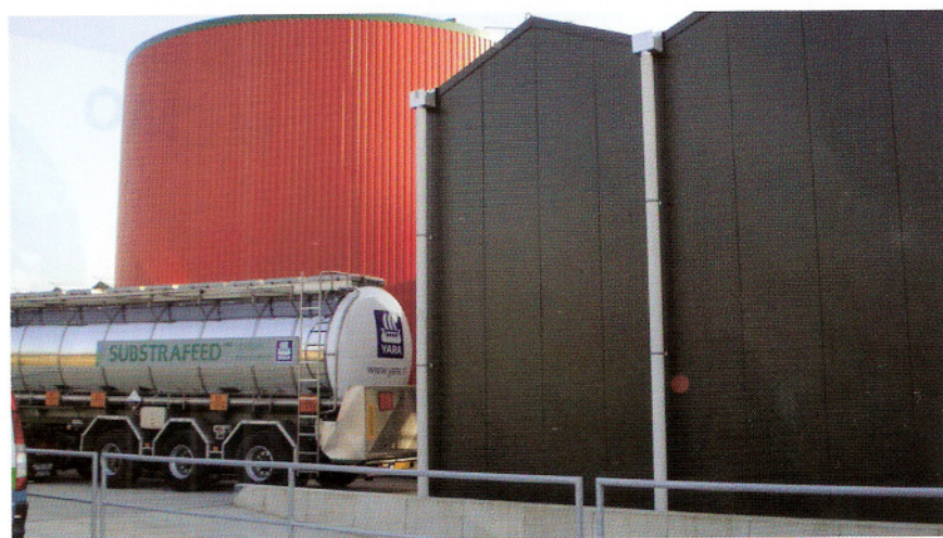
Buffertank en vloeibare meststoffen
